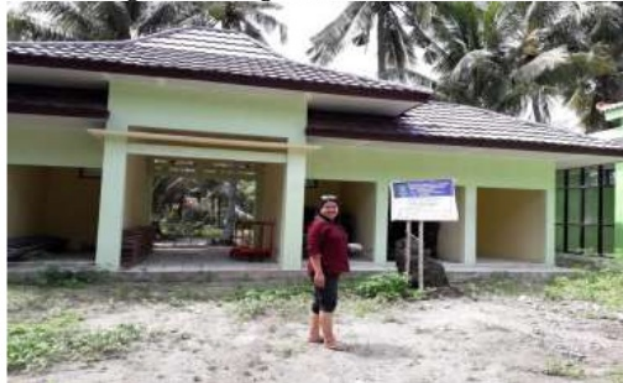
Gambar 9.1 Pembangunan Diving Sistem oleh Dinas Pariwisata
