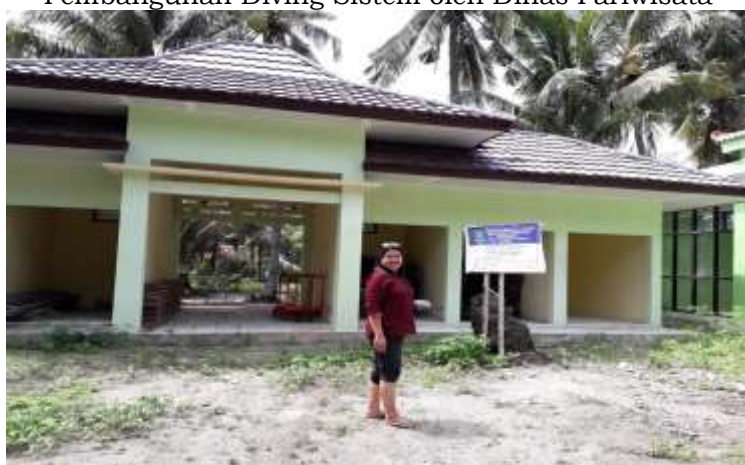
Gambar 9.1 Pembangunan Diving Sistem oleh Dinas Pariwisata
