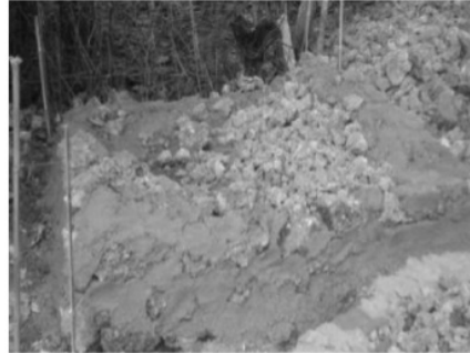
Gambar 5.5 Pembuatan Tempat Bak Penampung Desa Jate
