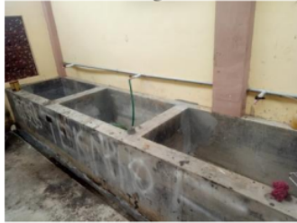
Gambar 2. Tempat Curing Beton
