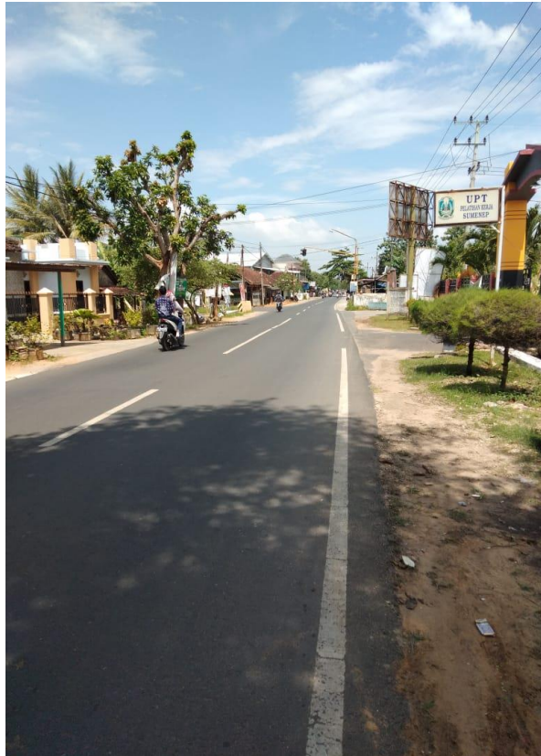
Gambar 1.1 Jalan Lingkar Utara Desa Parsanga Kecamatan Kota Kabupaten Sumenep
